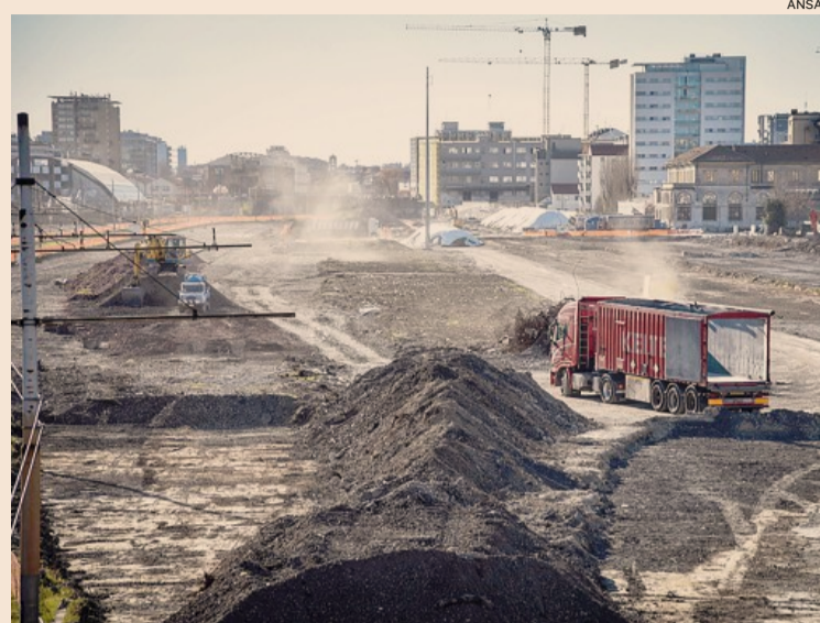
Cantieri aperti. La costruzione del villaggio olimpico a Milano
